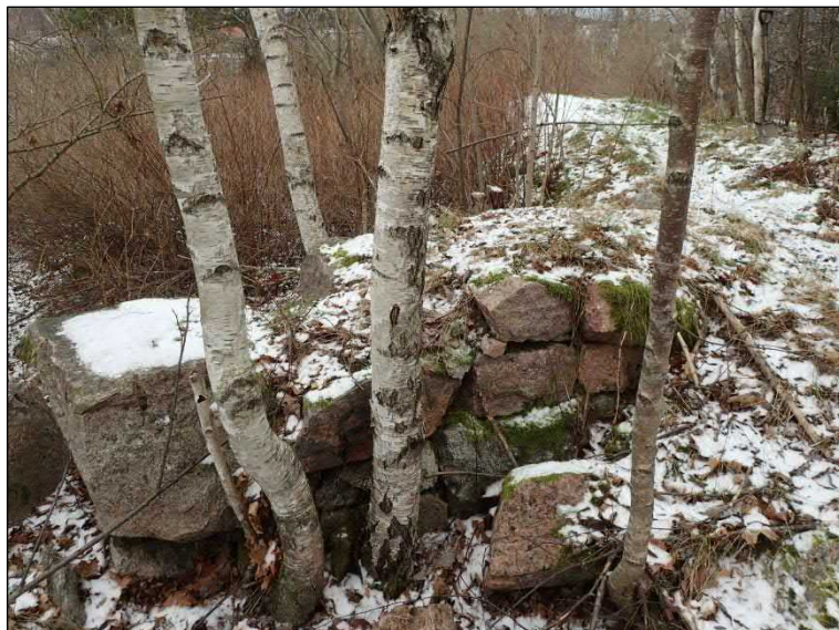
Rakennuksen perustan luoteispäätä
