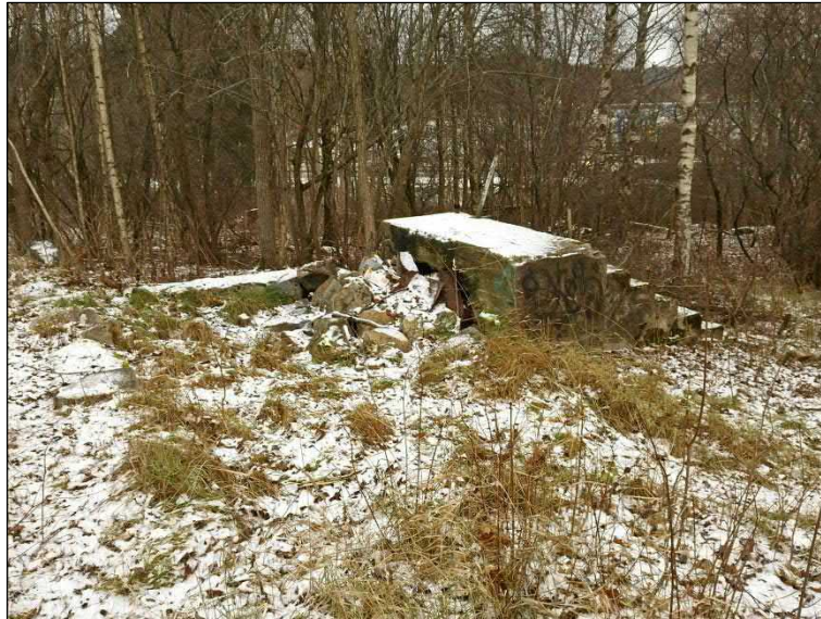
Mäen laella olleen rakennuksen betoninen porras, kaakkoon.
