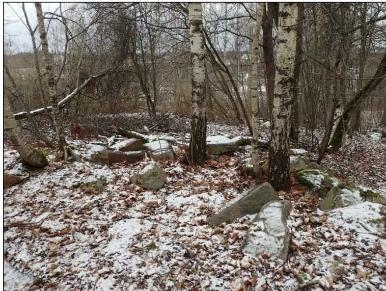
rakennuksen perustan koilliskulmaa, koilliseen.
