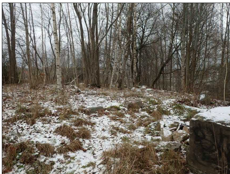
Rakennuksen perustaa pohjoiseen, oikealla porras.
