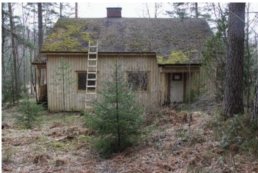
Rivningsfärdigt bostadshus från 1950-talet.
