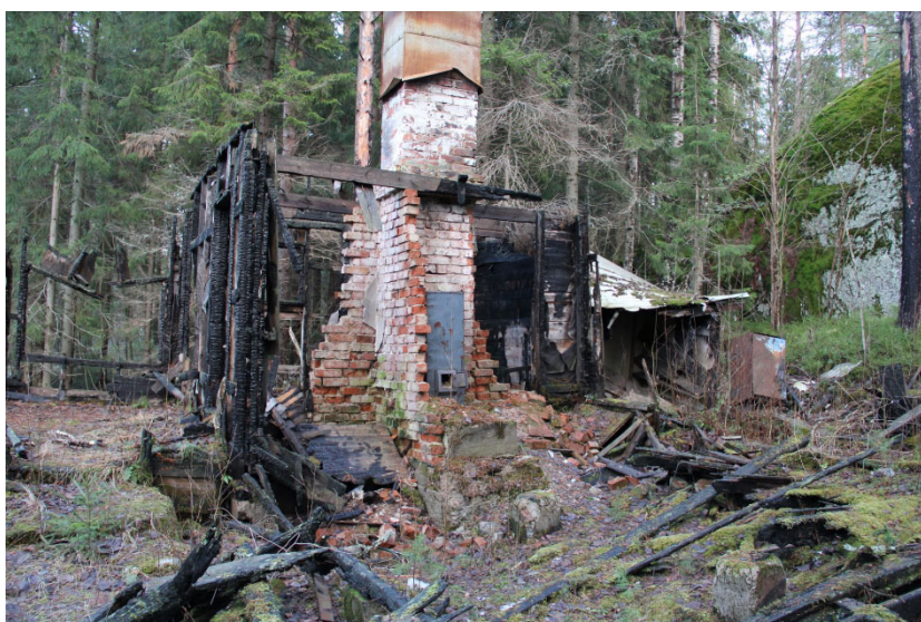
En sommarstuga som förstörts i en anlagd brand.
