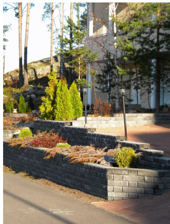
Pihan ja kadun välinen korkeusero on ratkaistu kivimuurilla. (kuva: Arja Sippola, Kirkkonummen Kolsarby)
