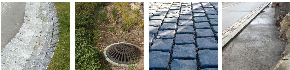
Erilaisia pintavesipainannevaihtoehtoja: luonnonkivistä ladottu kouru, istutettu painanne ja ylivuotokaivo, kivituhkasaumattu nupukivi sekä asfalttipintainen painanne
