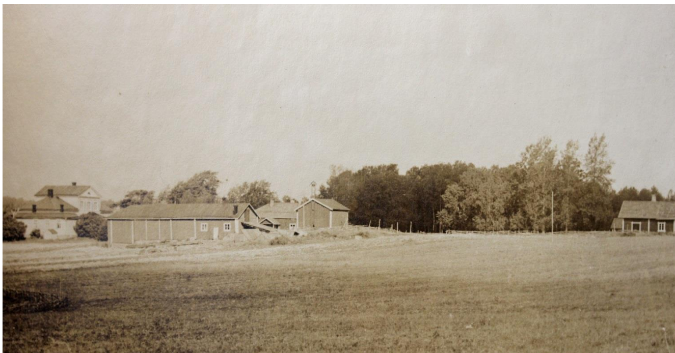
På västra sidan av Navalavägen, mellan åkrarna och stranden reser sig en liten skogskulle. Där byggdes ett lusthus redan under von Wahlbergs tid. KA
