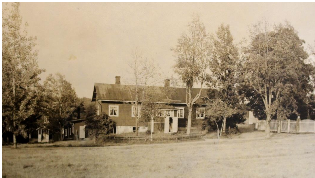
Huvudbyggnadens gårdsomgivning var en gång i tiden inhägnad, vilket de gamla portstolparna minner oss om. Längst till vänster syns också det gamla mejeriet. KA
