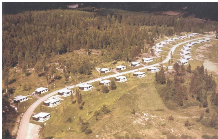
Kuva 5. Ristikalliontien pientaloalue vuonna 1968. Bild 5. Korsbergsvägens småhusområde 1968.
